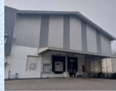
Cold Storage dan tempat loading container ekspor
